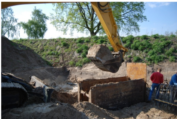
Baugrube mittels Verbau
