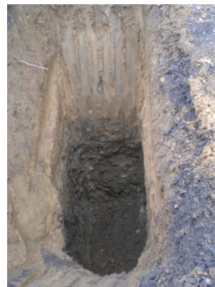
Baugrube ohne Verbau
