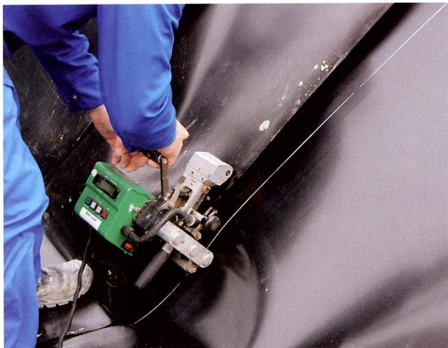
Verschweißung des Speicherkörpers mittels PP-Spezialfolie mit anschließender Dichtigkeitsprüfung
