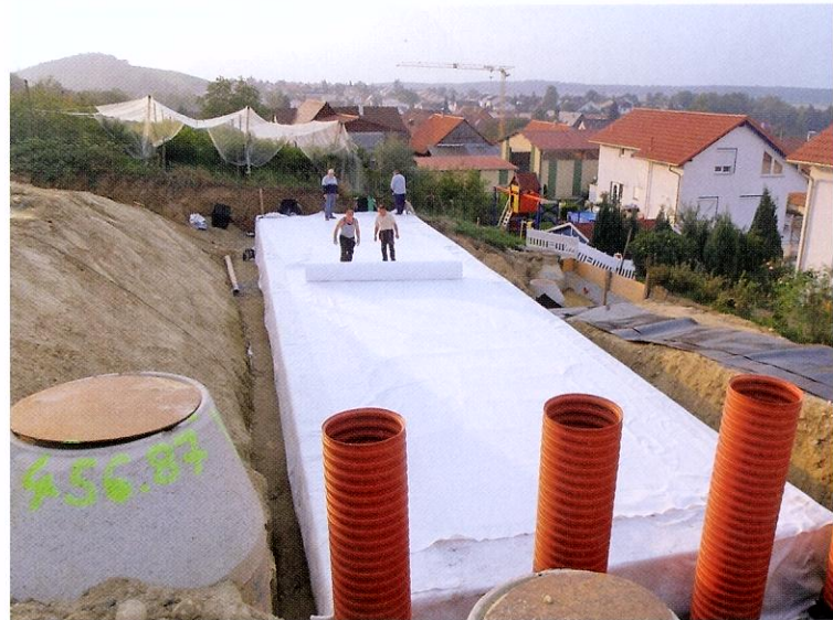
Die nahezu fertiggestellte Regenwasserrückhaltemaßnahme
