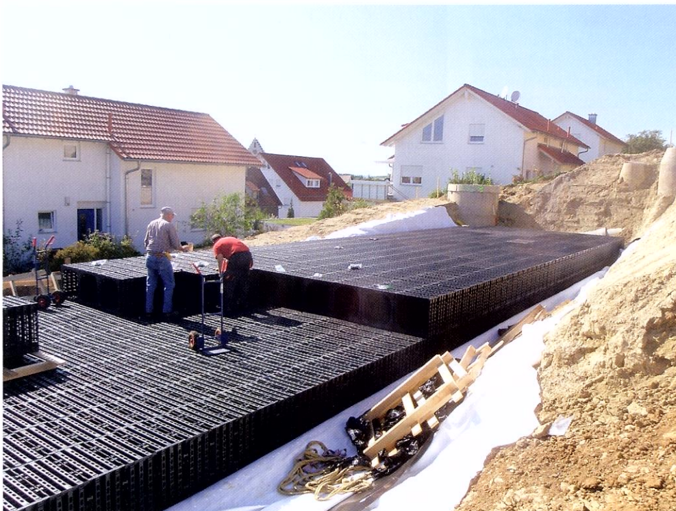
Einbau der TÜV-Nord-geprüften Hohlkörpersysteme.
